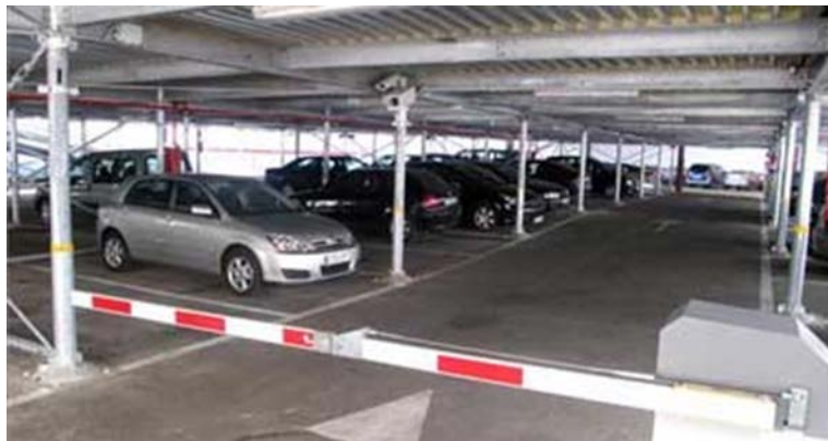
Figura 1. Puerta de entrada al parking
