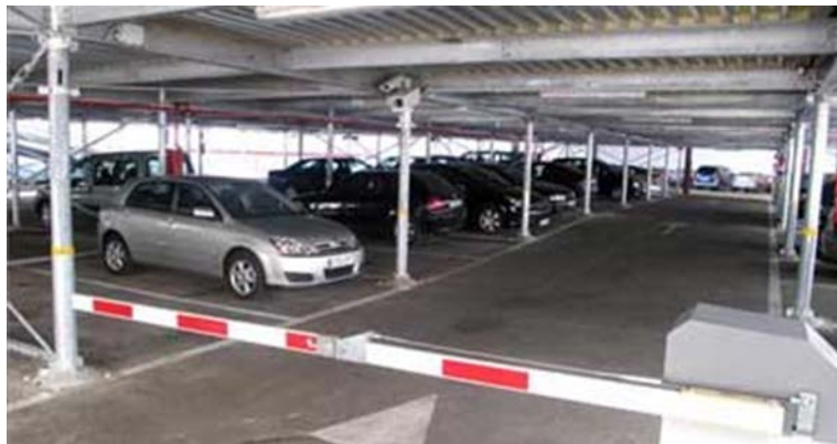
Figura 1. Puerta de entrada al parking
